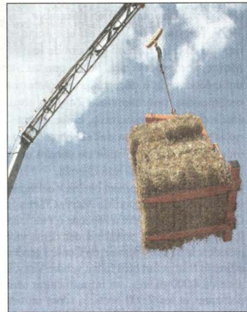
Ici, la paille est utilisée comme matériau isolant.
